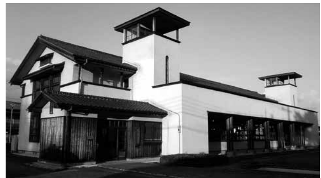
写真1 栃木県真岡市「久保講堂」外観
